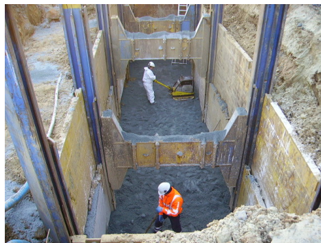
Beschoeiingbox: een betrouwbare oplossing voor ontgravingen tot 7 m-mv.
