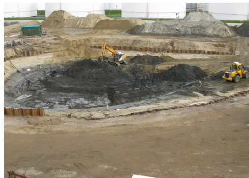
Damwanden, Secanspalen, Berlinerwanden: De ideale grondkering voor grote bouwputten.
