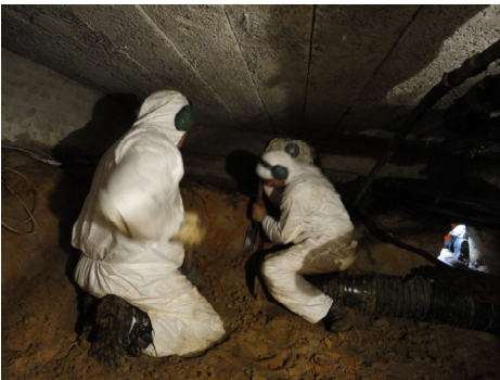
Ontgraven van kruipruimte. Combinatie van manueel ontgraven + grondzuiging
