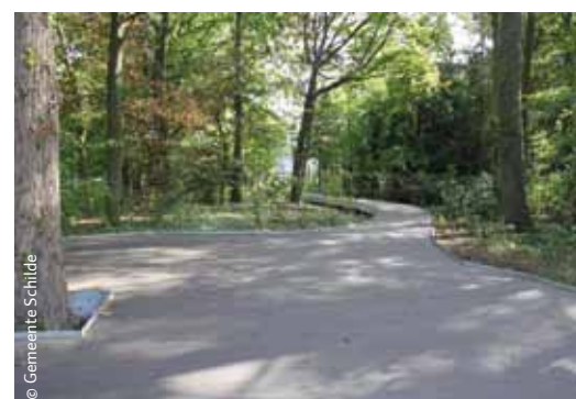
Het vlonderpad meandert door het park, waarbij bestaande groenelementen werden geïntegreerd.
